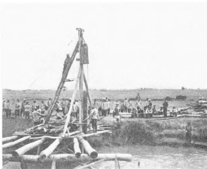
Постройка моста черезъ рѣчку.
