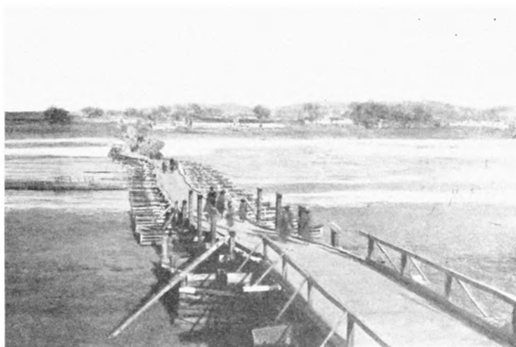
Ледоходъ при содержаніи моста.
